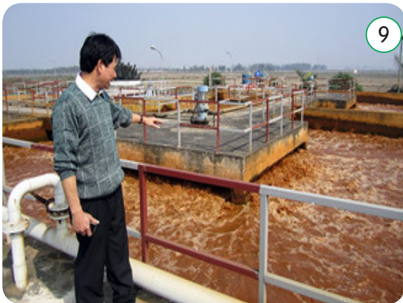
Xây dựng trạm xử lý nước thải ở các khu công nghiệp ở Hưng Yên
