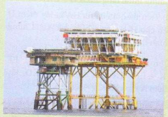
Nhà giàn đứng vững được giữa biển khơi nhờ được tăng cường sự chắc chắn với các ê ke ở các góc trụ nhà giàn.
