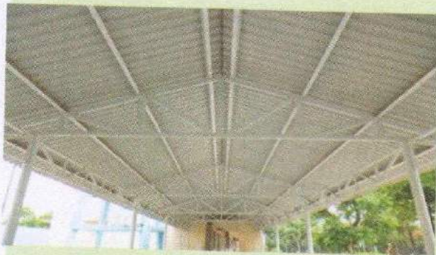
Khung mái nhà với cấu trúc hình tam giác.
