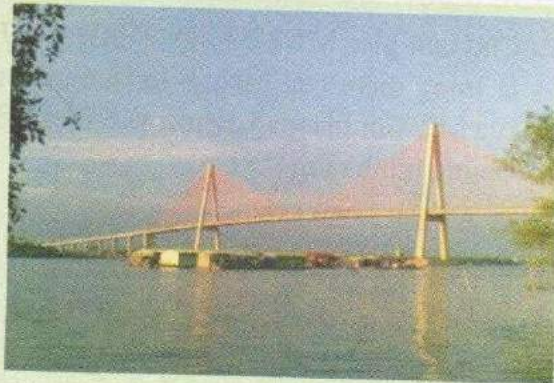
Cầu Rạch Miêu, nối hai tỉnh Tiền Giang và Bến Tre với các trụ cầu hình tam giác.
