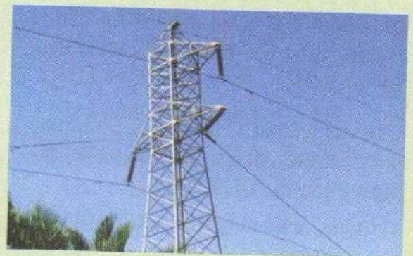
Trụ điện với các thanh thép kết nối hình tam giác.
