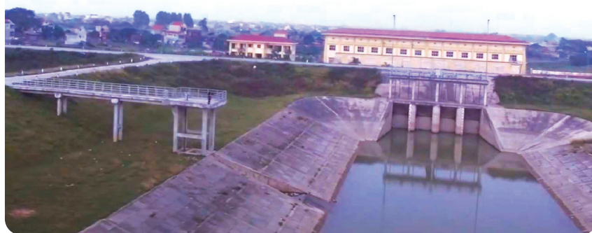
Hình 6. Trạm tưới tiêu (thôn Nghi Xuyên, xã Chí Tân, huyện Khoái Châu)
